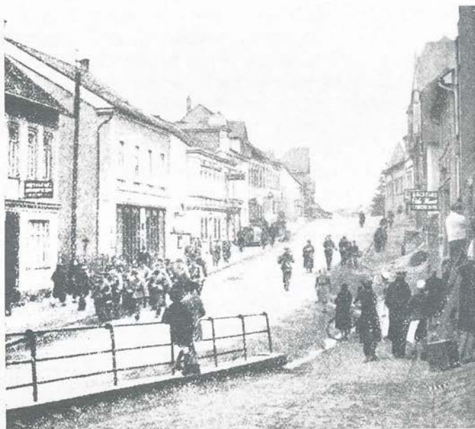
SS in der Frankfurter Straße Camberg
