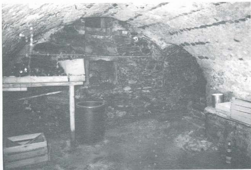
Das Kellergewölbe vom Wohnhaus der Barbara Ordeneck in Würges, Schulstraße Nr. 6 (Foto: K. H. Braun)
