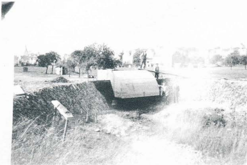
2. Staustufe am Ortseingang Camberg ("Kaspar August") Fotos: Archiv Kunz
