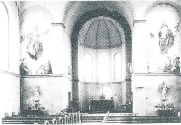
Kirche nach der Renovierung 1965
