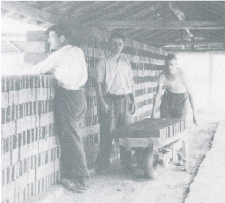
Arbeiten in der Ringofenziegelei in Camberg
