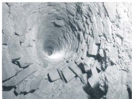
Der gemauerte Lüftungsschacht des unteren Gewölbekellers
