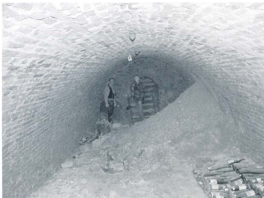
Der untere Eiskeller von Norden. Hinten links ist der Beginn des Laufgangs, in der Mitte die Treppe zum darüber liegenden Keller, und rechts der Zugang zu einem weiteren, kleinen Nebenkeller erkennbar. Die Aufschüttung resultiert aus einem Gewölbeeinbruch zum höher gelegenen, kleinen Keller.
