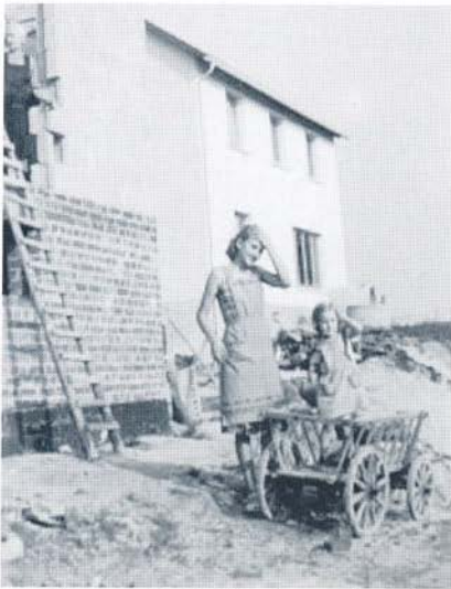
Transportmittel für Baumaterial
