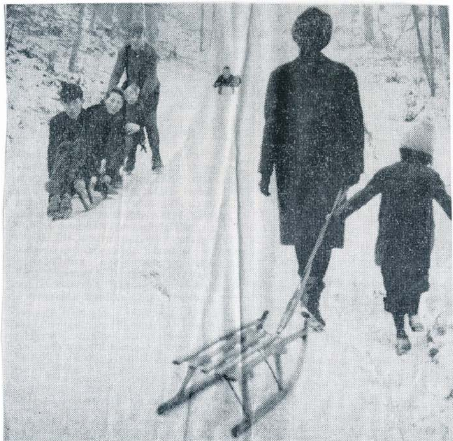
Im Sommer ein sehr gern begangener und schattiger Spazierweg, im Winter vorzügliche und ungefährliche Rodelbahn ist der Weg im ehemaligen Stadtgraben Kuranlagen. Nicht nur Jugendliche, auch Erwachsene rodeln gern auf Gefällstrecke.
