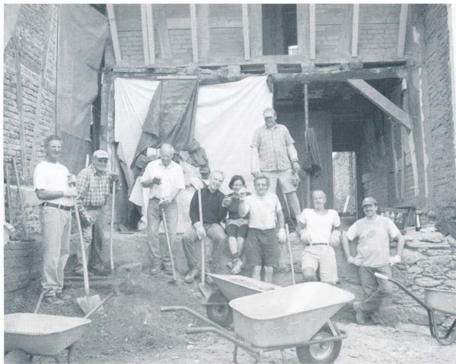
Fleißige Helfer beim Arbeitseinsatz am Bürgerprojekt „Alte jüdische Schule“
