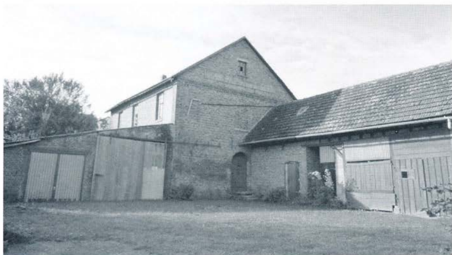
Hofansicht des Produktionsgebäudes der Alten Essigfabrik. Am Giebel ist das Schild „Essigfabrik von G. Send“ zu sehen, auf der rechten Seite des Bildes befindet sich die Remise mit der ehemaligen Küferwerkstatt. (Fotos: Johannes Gerstenberg)
