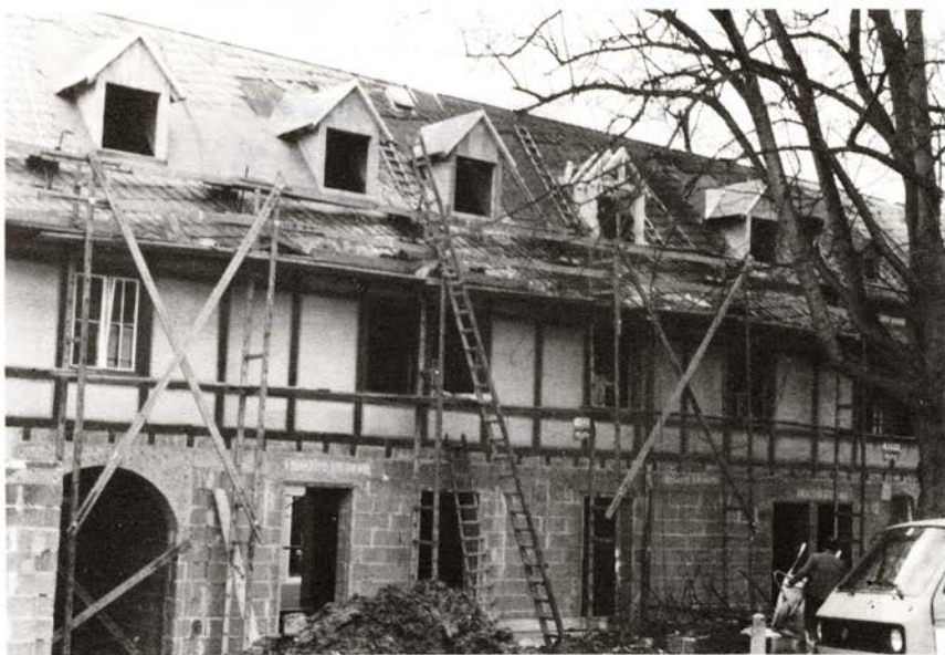
Amthof-Renovierung, Stand Februar 1989
