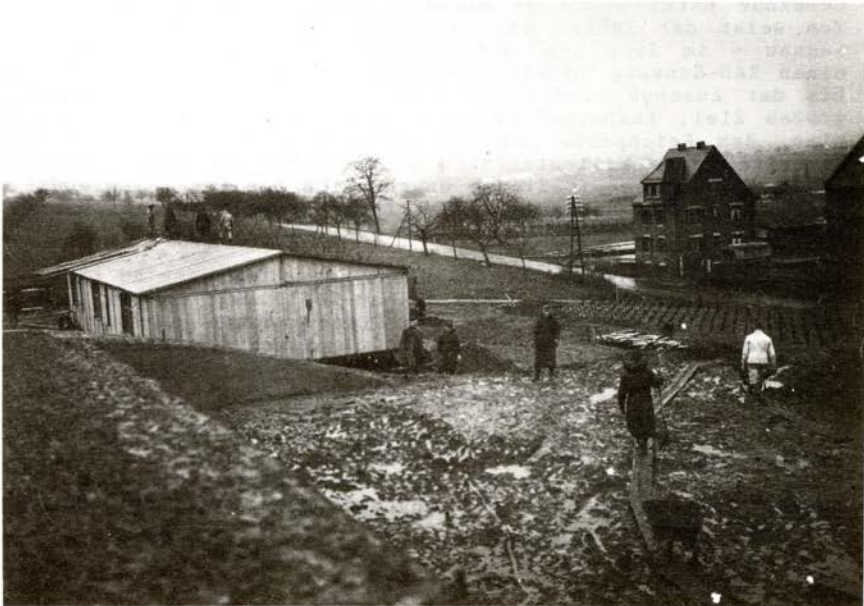
Lager im Bau, Blickrichtung Würges
